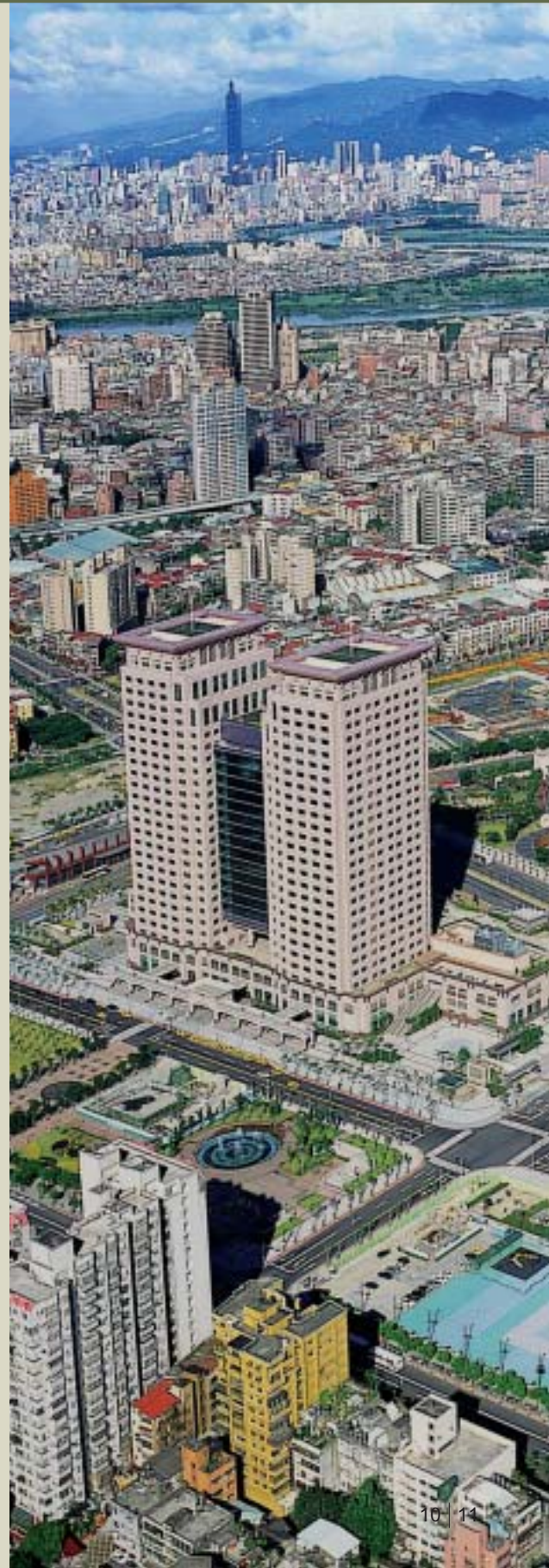
新板橋車站 New Banciao Station
