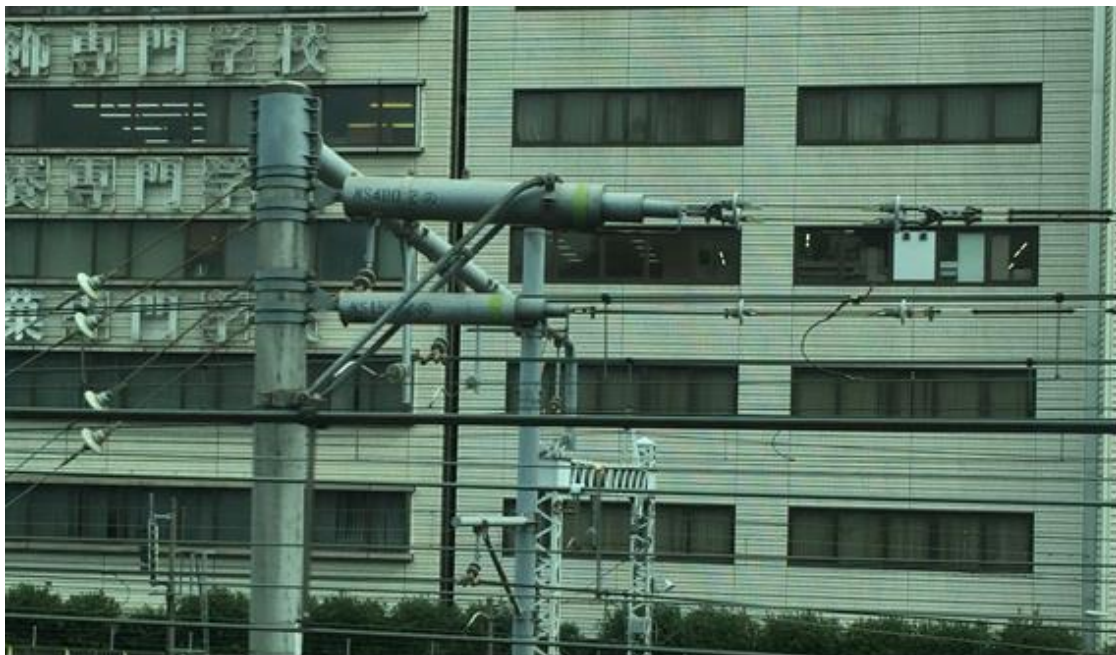
圖 1.10 油壓套管型自動裝力裝置
