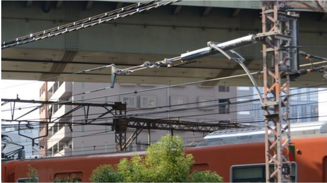
圖 1.9 油壓套管型自動張力裝置
