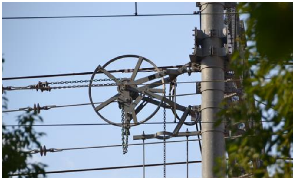
圖 1.8 一般重錘式自動平衡裝置
