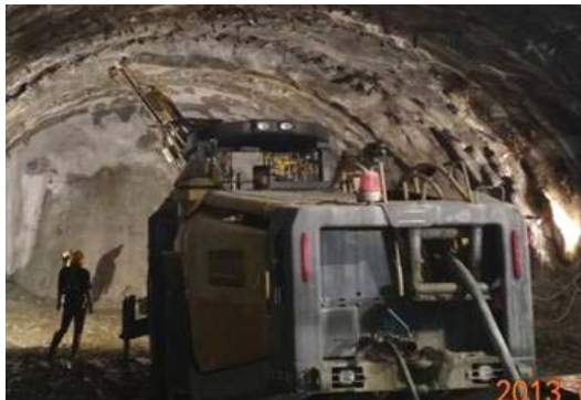
打設前進鋼管
