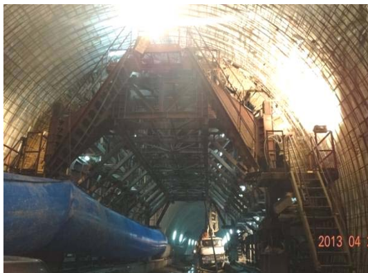
混凝土襯砌灌漿
